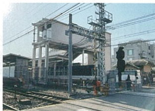
高架化される諏訪ノ森駅舎
